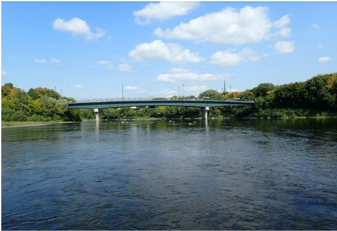
Figure 19. Vue de la station Pont Concorde le 16 septembre 2017
